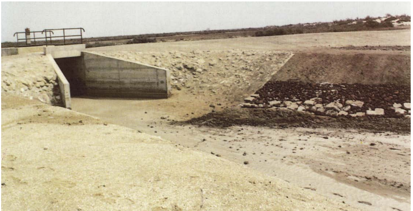
Photo n° 4 : Réparation d'érosions similaires survenues à l'aval de l'ouvrage de Lekser en 1996. Ces réparations (juin 1997) ont bien résisté aux débits beaucoup plus importants de l'inondation 1997.
